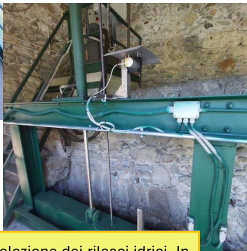
Vista delle attrezzature montate per la regolazione dei rilasci idrici. In alto vista della paratia, in basso strumentazione di controllo
